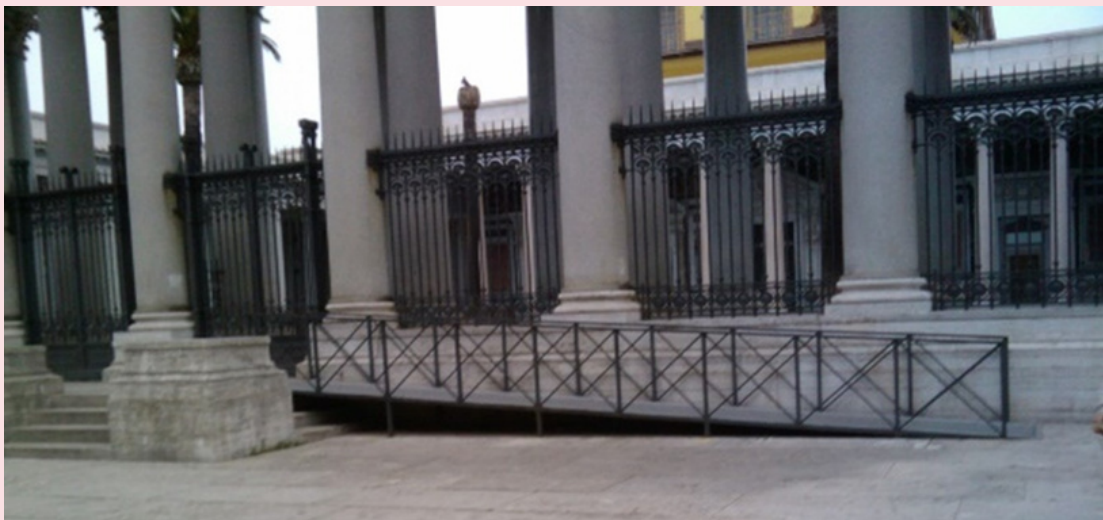
Ilustración 10: Esta rampla ten a lonxitude necesaria para subir a altura dos case catro banzos que ten San Pablo Extramuros en Roma.
